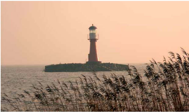
8 pav. Kuršių marių navigacijos statiniai. Pervalkos švyturys Fig. 8. Navigation structures at the Curonian Bay. Lighthouse in Pervalka
